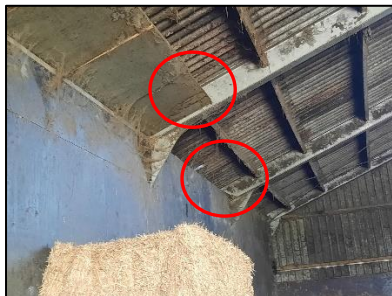
Figuur 18. Ruimte tussen houten platen en het metalen dak met een rode cirkel gemarkeerd (opstal 1).
