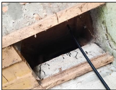
Figuur 25. Opening naar zolder in de schuur (opstal 2).
