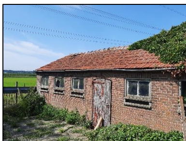
Figuur 9. Buitenzijde van het vervallen schuurtje, zicht vanuit zuidelijke richting (opstal 4).
