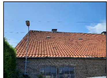
Figuur 6. Buitenzijde van de schuur, zicht vanuit noordelijke richting (opstal 2).
