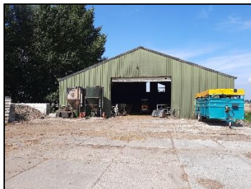
Figuur 4. Buitenzijde van de koeienstal, zicht vanuit zuidelijke richting (opstal 1).
