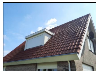
Figuur 9. Buitenzijde van de woning, zicht vanuit westelijke richting (opstal 3).
