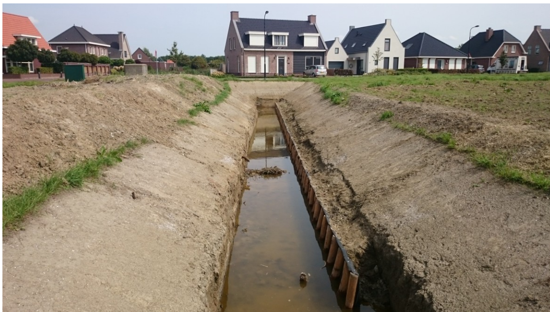
Nieuw aangelegde watergang in het noordoostelijk deel van het plangebied. De bebouwing op de achtergrond betreft de woningen langs de Frederik Bollaan. Foto: A. van Meurs, Ecoresult B.V.
