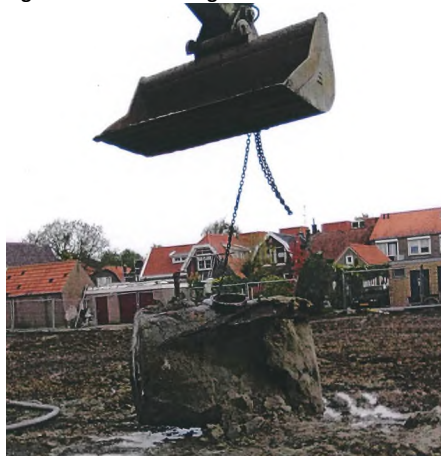
Figuur 2.2 Tanksanering 26 oktober 2010
