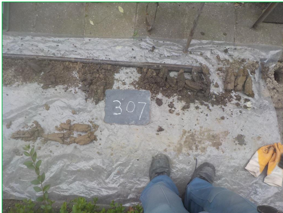
Foto 11. Impressie uitkomend materiaal boring 307.
