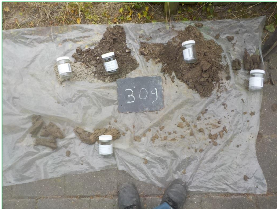
Foto 13. Impressie uitkomend materiaal boring 309.
