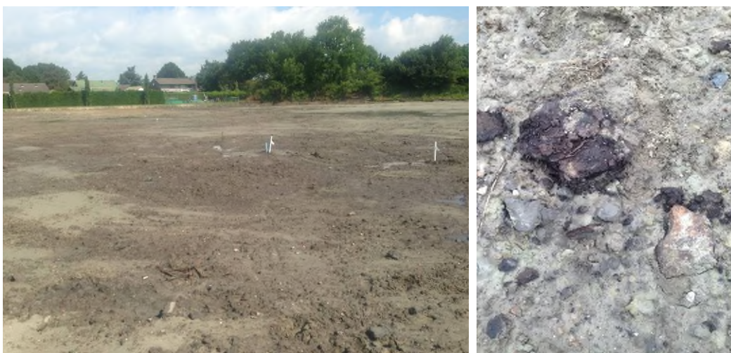
Afbeelding 19. Foto's van het oppervlak van het braakliggende perceel waar recent de bebouwing is gesloopt. Links een overzicht met daarop de aanwezige peilbuizen en rechts een detail van de veenbrokken en puinresten.
