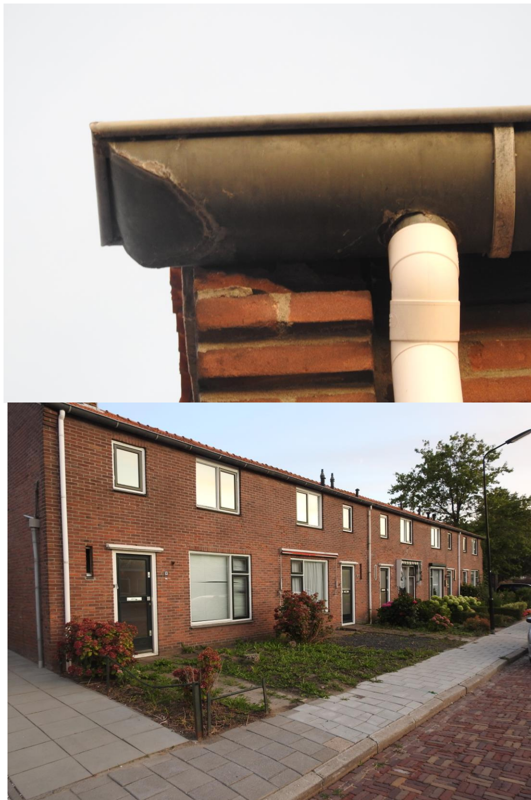
Foto 4. Voorzijde te slopen woningen.
