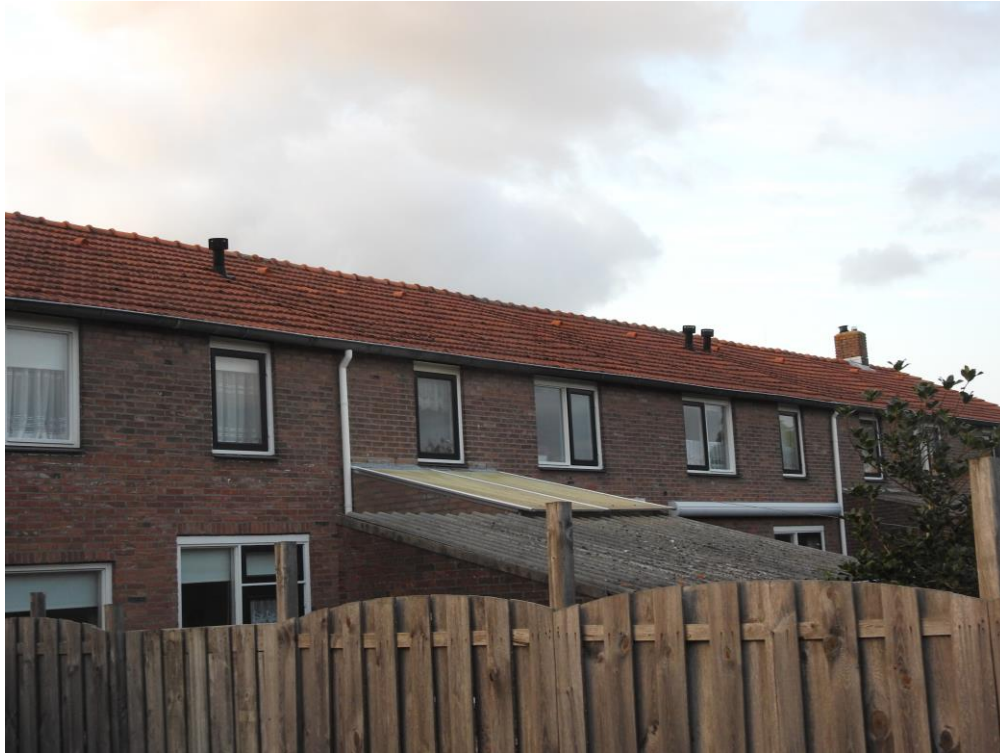
Foto 5. Achterzijde te slopen woningen.
