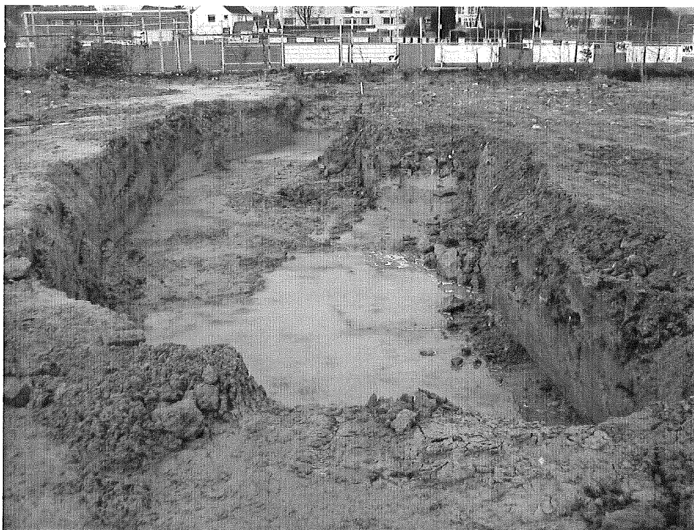
F.01 : overzicht vanaf noordzijde
