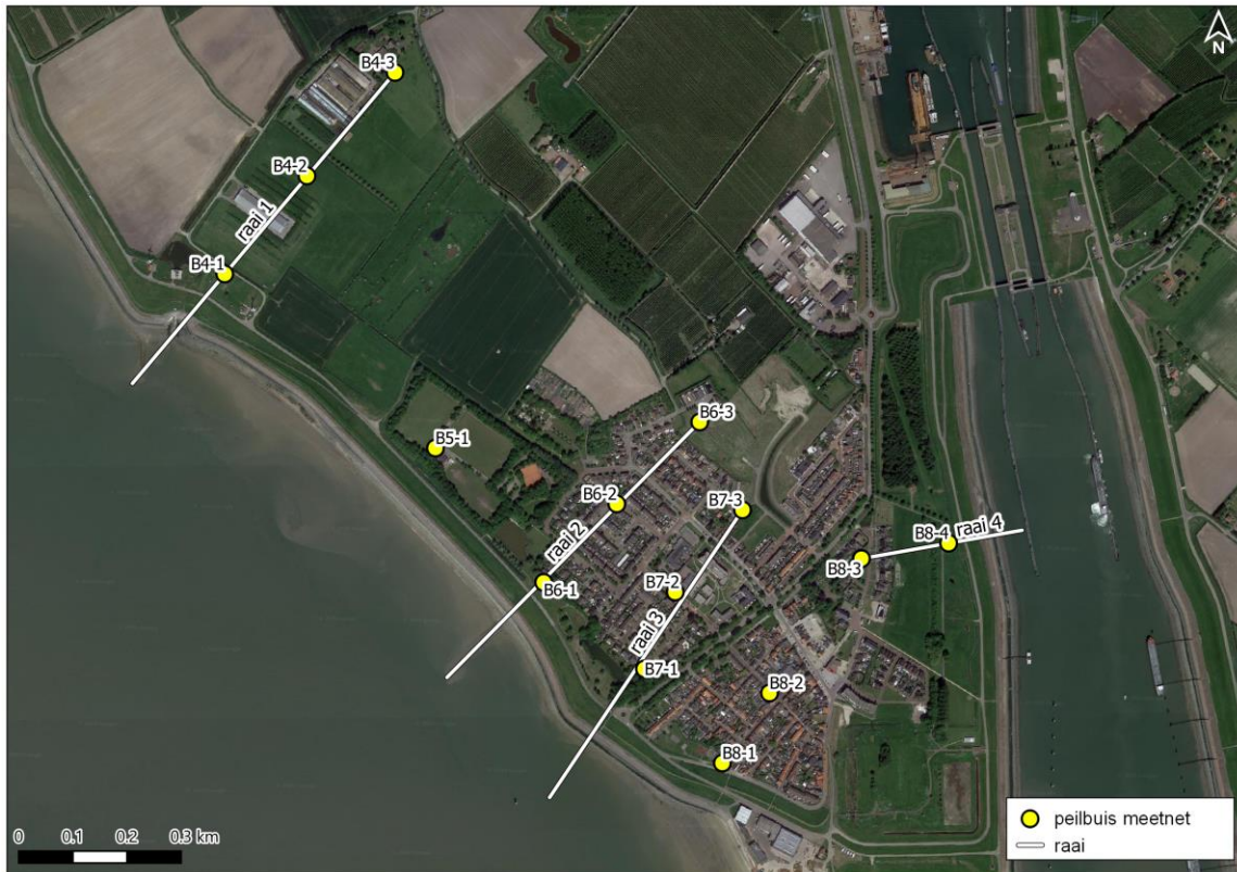
Afbeelding 4.5 Overzicht meetraaien en peilbuizen Hansweert
