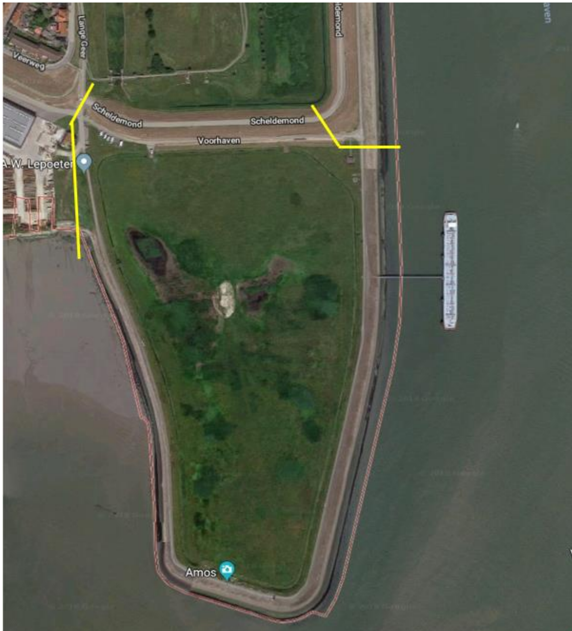
Afbeelding 2.4 Luchtfoto Slibdepot, dijksectie tussen gele markeringen (www.google.com/maps)
