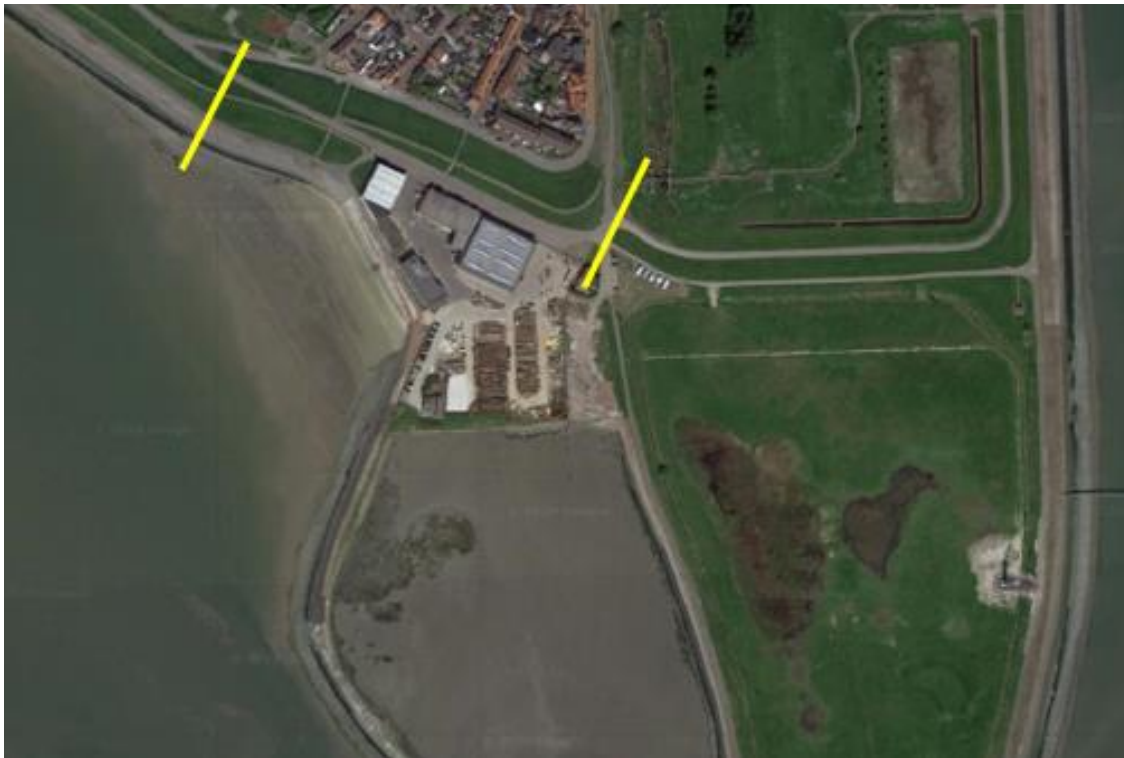
Afbeelding 2.5 Luchtfoto huidige situatie Dorpsrand Werfdijk, dijksectie tussen gele markeringen ( www.google.com/maps )
