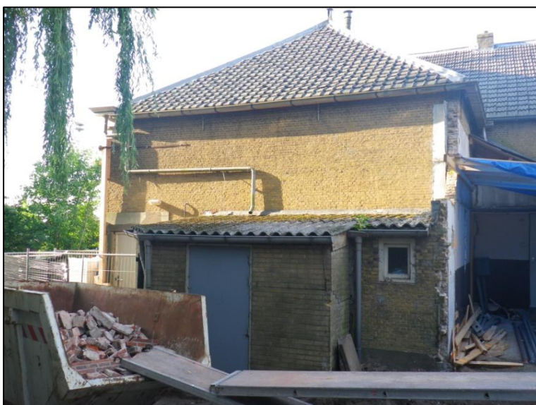
Figuur 2: Het plangebied, gezien vanuit het zuidoosten (boven) en het noorden (onder).
