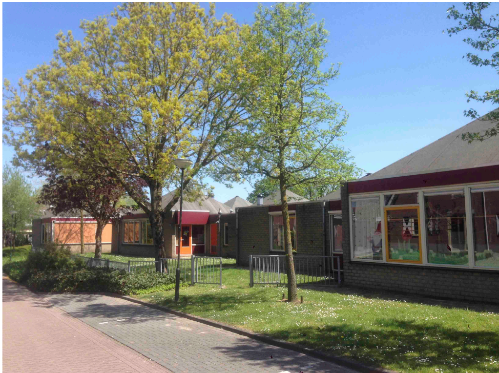
Figuur 2 De bestaand bebouwing wordt gesloopt ten behoeve van een te realiseren multicultureel centrum.
