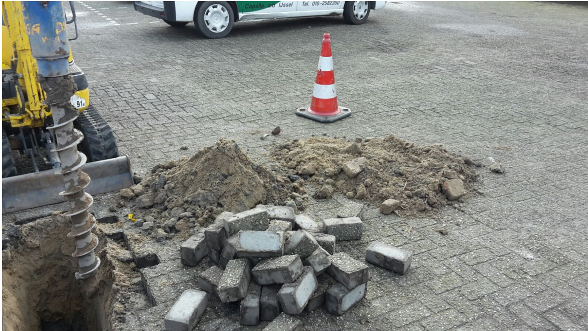
Foto 1: Gat t.b.v. asbestonderzoek AS1
