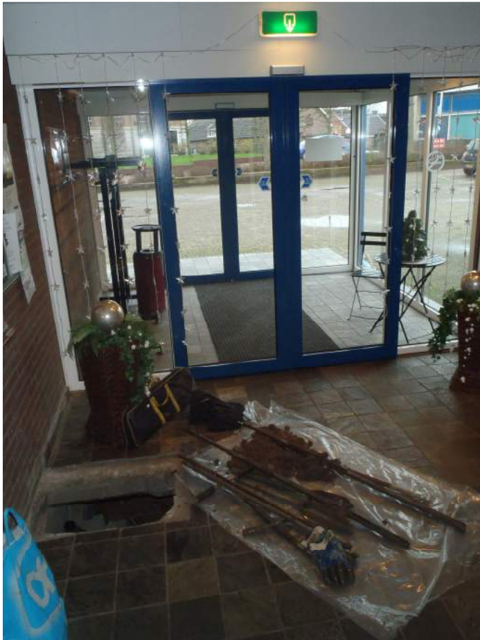
Afbeelding 5: impressies van de inpandige boringen 008 (links) en 009 (rechts).
