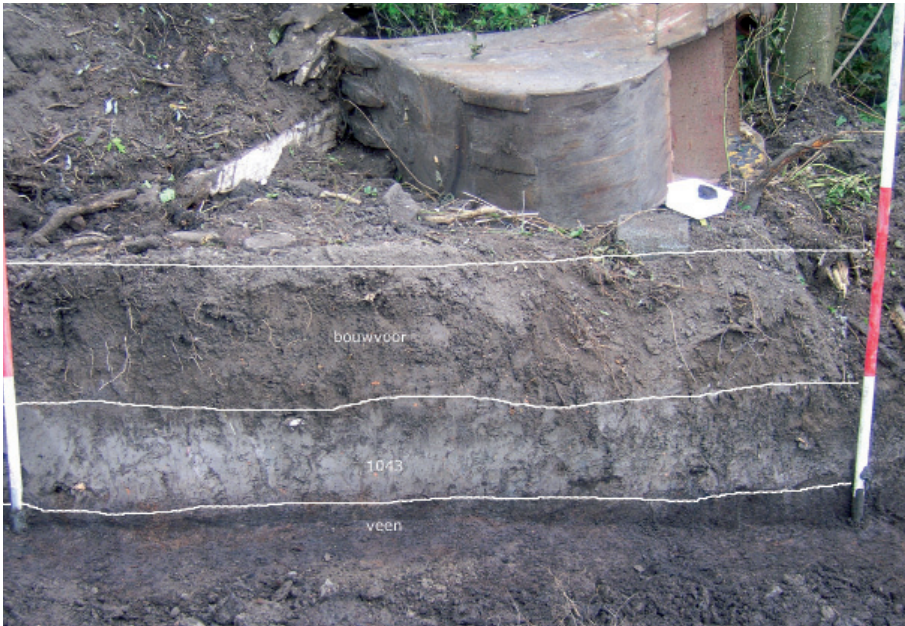
Afb. 3.01 a Foto van een deel van het oostprofiel aan de noordzijde van de proefsleuf. Onderaan is boven het grondwater nog net het veen zichtbaar. Direct daarboven bevindt zich een laag met verspit veen. De rest van het profiel bestaat uit ophogingslagen en enkele kuilen.
