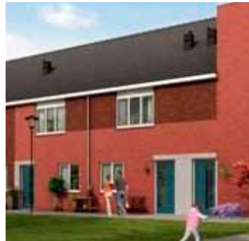
spel met twee kleuren metselwerk, horizontale koppelingen
