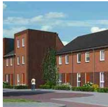
spel met twee kleuren metselwerk, samenhang voor- en zijgevels
