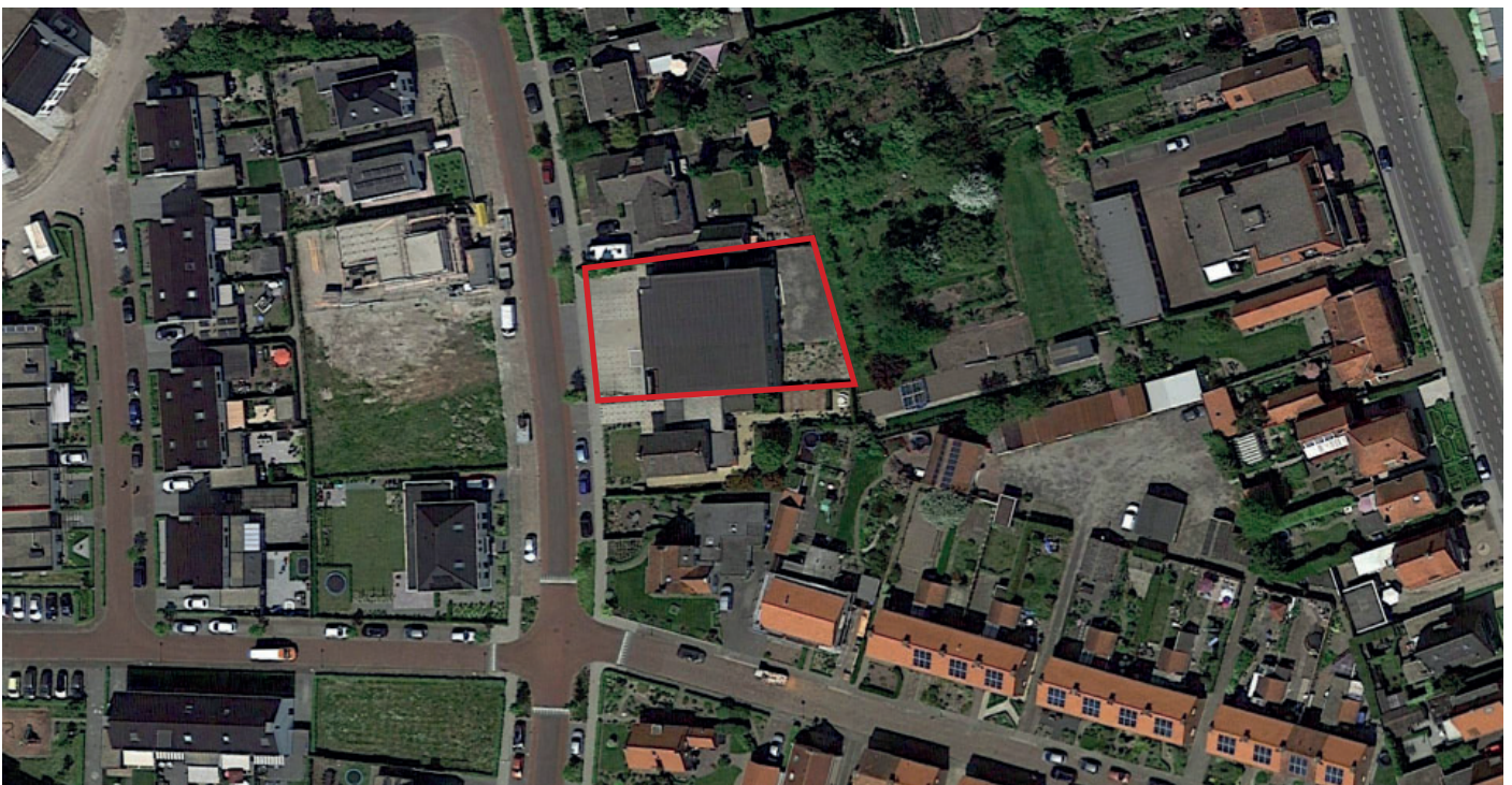
Figuur 2.1 : Luchtfoto locatie
