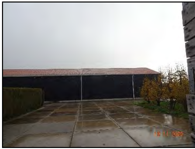
Figuur 6. Opstal ten noorden van de onderzoekslocatie.
