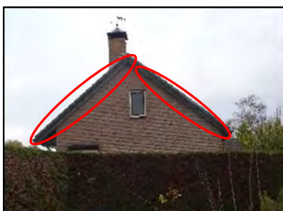
Figuur 12. Woning, met ruimte onder dakrand, kantpannen (aangegeven met rode cirkels) en dakgoot, direct ten noorden van de onderzoekslocatie.
