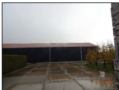
Figuur 6. Opstal ten noorden van de onderzoekslocatie.
