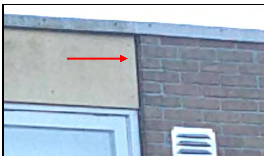
Afbeelding 3: Spleet langs kozijnen en beplating
