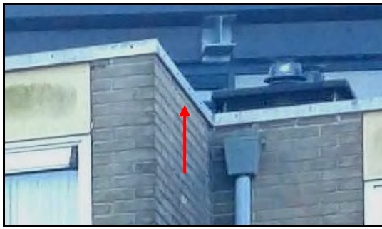
Afbeelding 5: Ruimte achter daklijst
