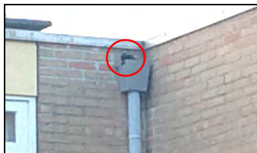
Afbeelding 4: Opening in gevel bij hemelwaterafvoer
