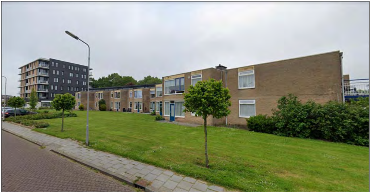
Figuur 16 Het plangebied gezien vanaf de Bruëlisstraat, vanuit het noordwesten. Op de voorgrond een deel van de te slopen bebouwing daterend van rond 1970, links op de achtergrond de nieuwbouw uit 2016. Bron: Google Streetview, geraadpleegd op 2 februari 2021 (opname van mei 2019).
