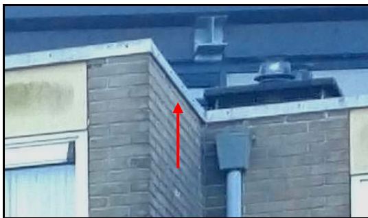
Afbeelding 6: Ruimte achter daklijst
