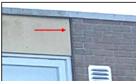
Afbeelding 4: Spleet langs kozijnen en beplating
