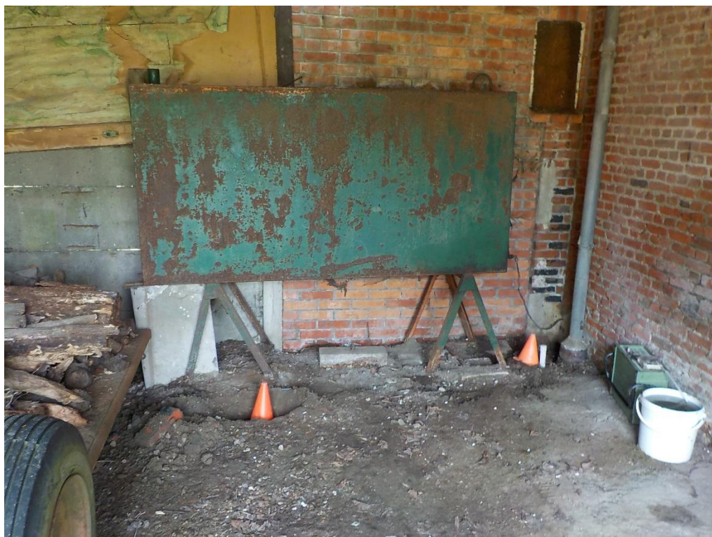
Foto 1: Bovengrondse tank (voor foto locatie en richting zie bijlage 2)
