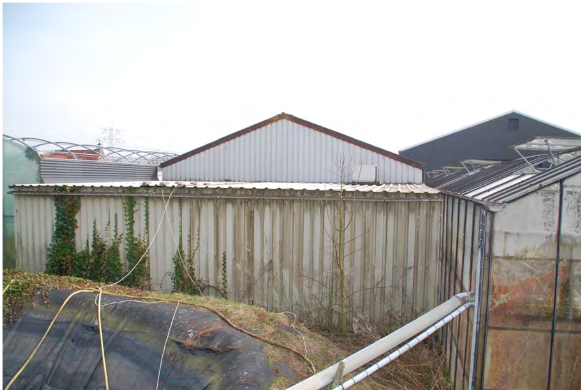
Foto 4. Te slopen schuur en kassen achterzijde.
