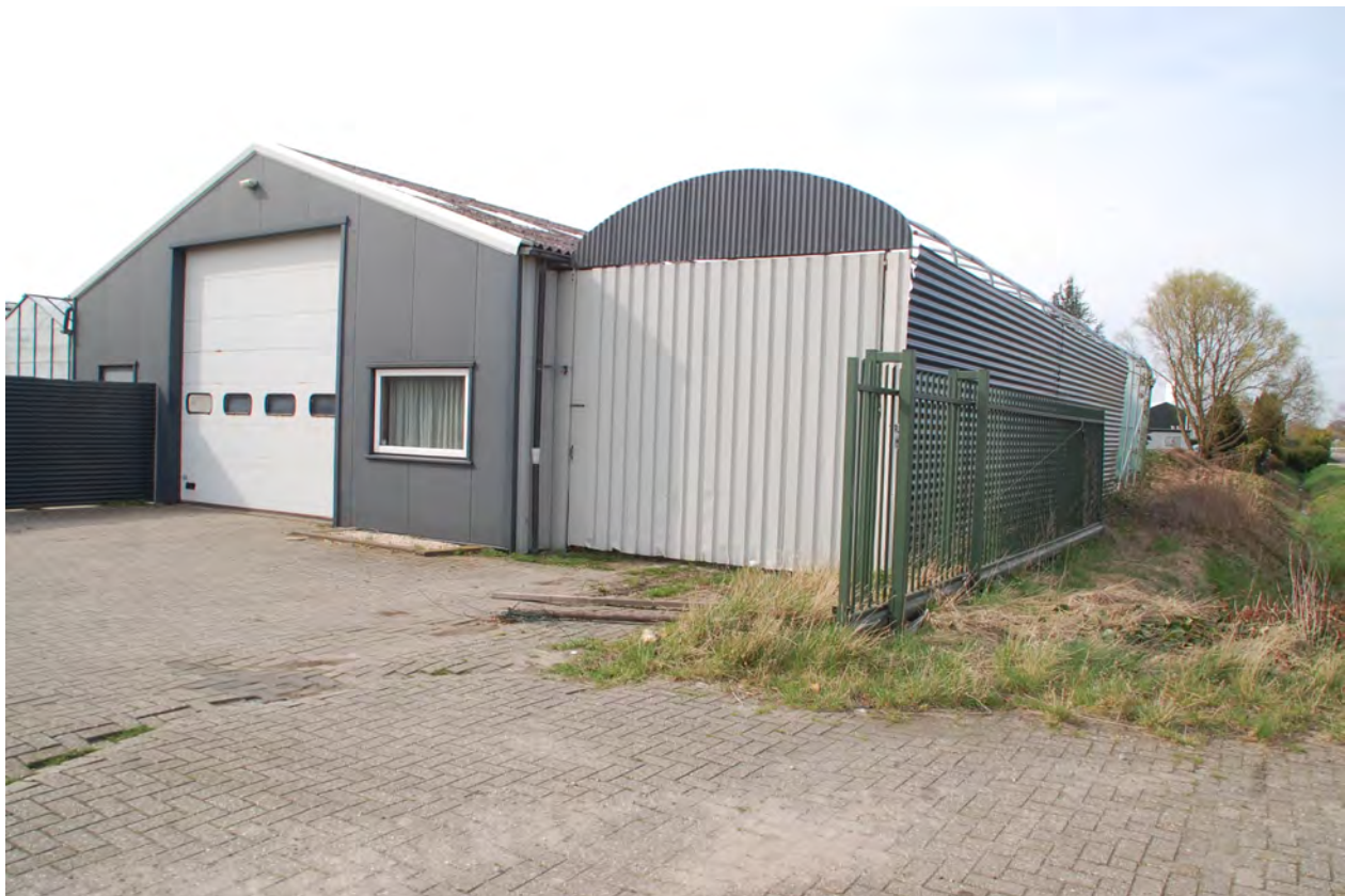
Foto 1. Te slopen schuur en afdak Noordhoeksewegeling 3.
