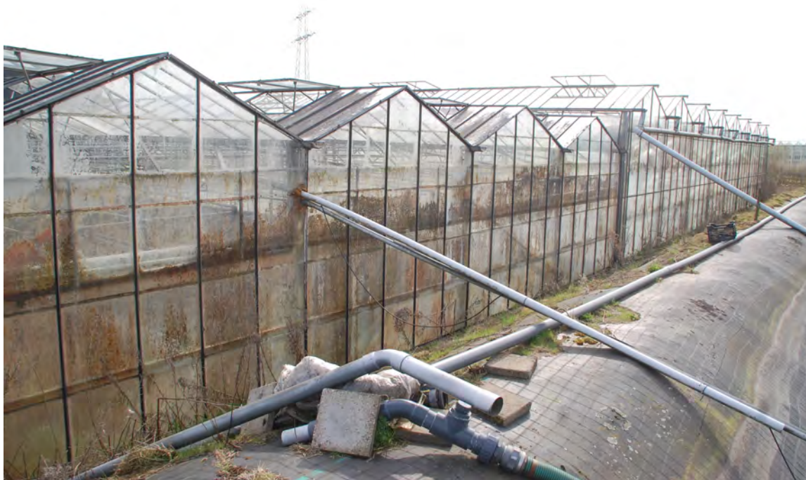
Foto 5. Te slopen kassen achterzijde.
