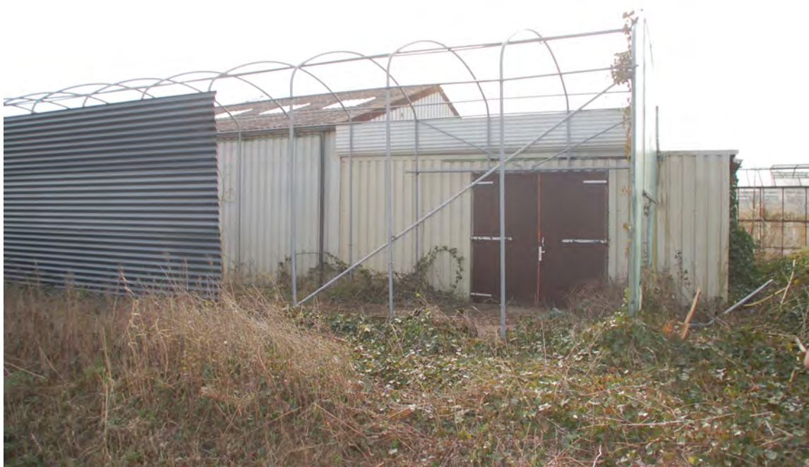
Foto 3. Te slopen schuur en afdak aan achterzijde.
