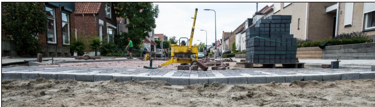
Foto 2: Aanleg weg met hol wegprofiel.
