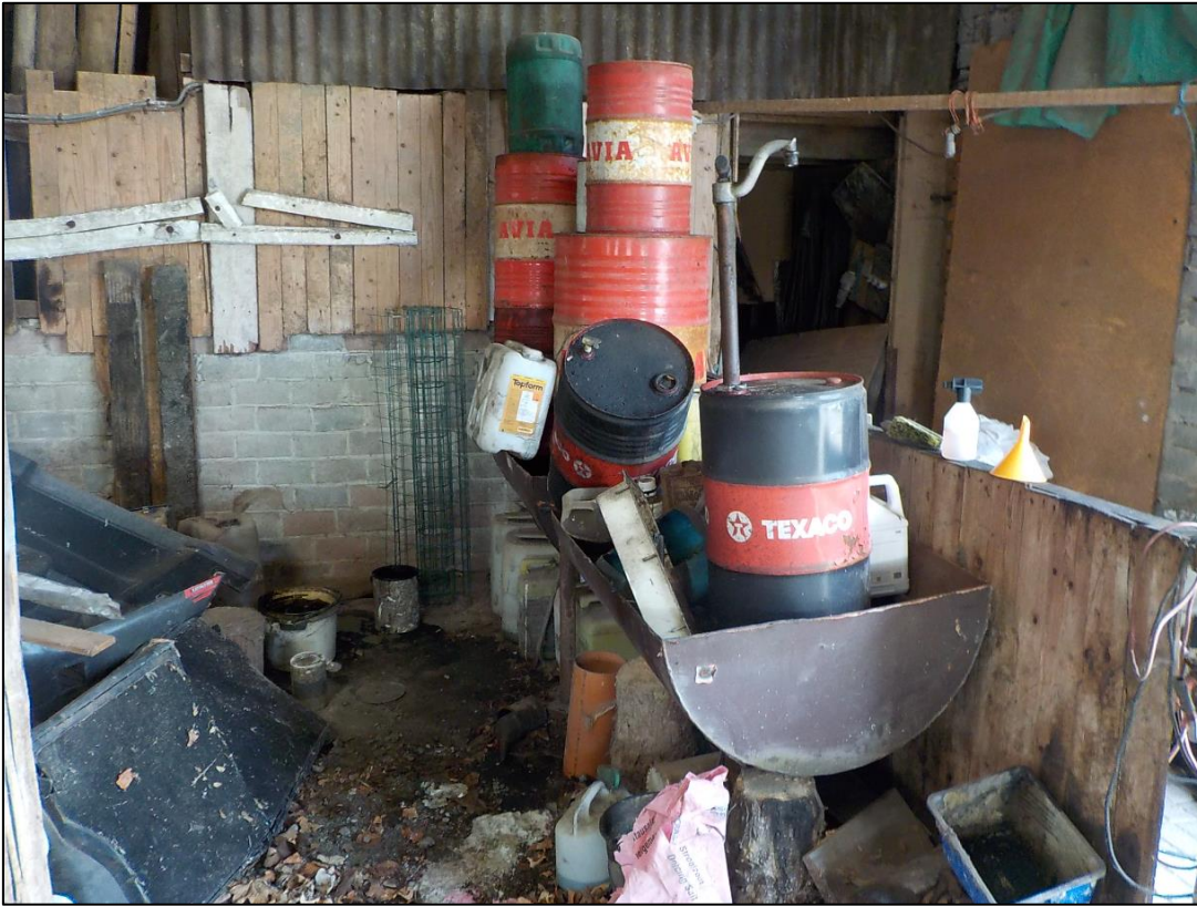
Foto 5: Olie opslag inpandig in loods (deellocatie 1)
