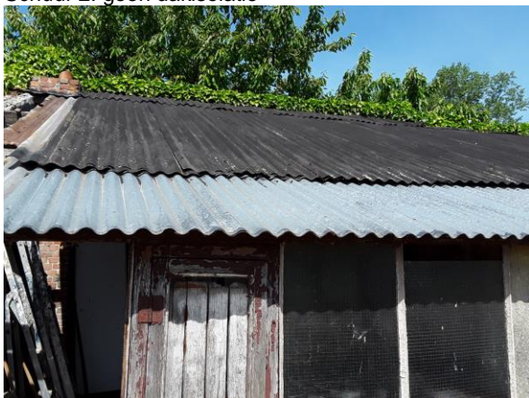
Kippenhok: bitumen en metalen dakbeplating
