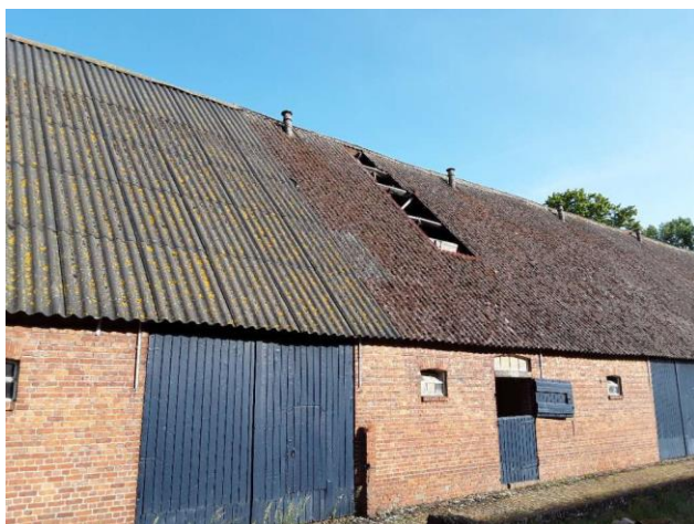
Dak schuur 1 (achterste deel)
