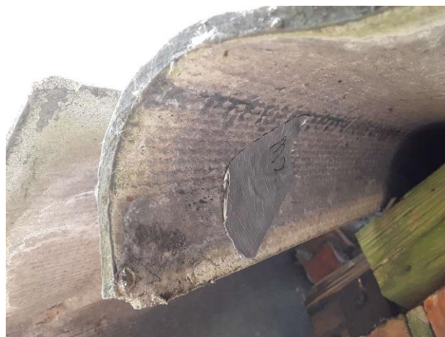
Dak schuur 1 (achterste deel)
