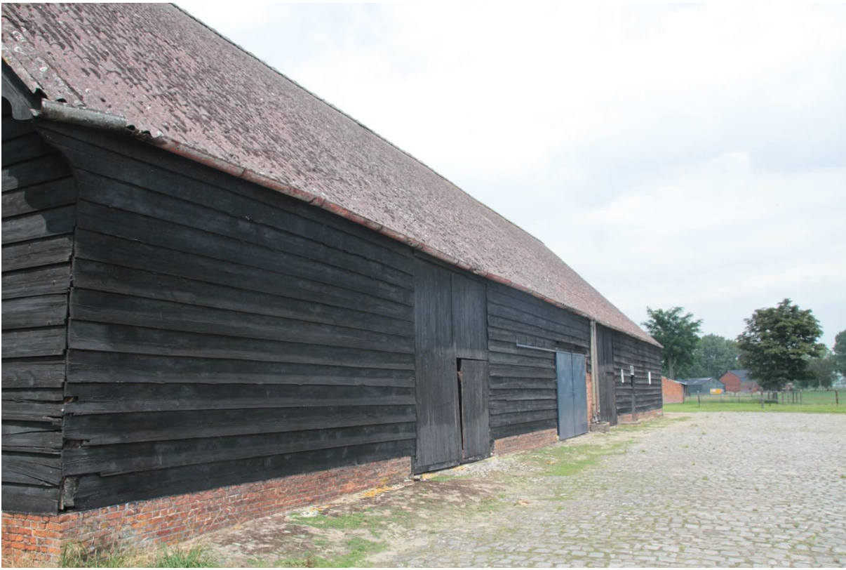
Foto 2. Overzicht van de te slopen zuidelijke schuur.
