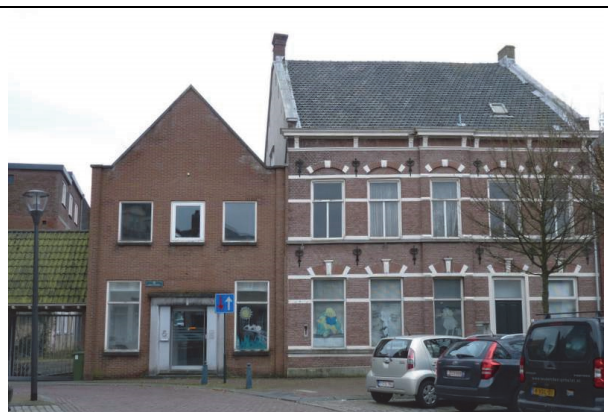
Fig. 8 Overzicht karakteristiek bankgebouw en naastliggend gebouw
