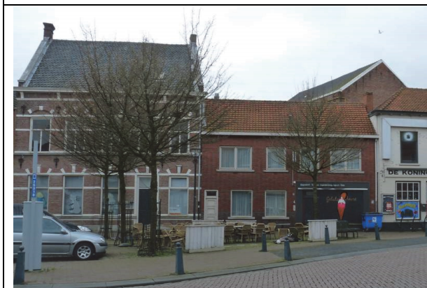
Fig. 7 overzicht kapsalon en karakteristiek bankgebouw
