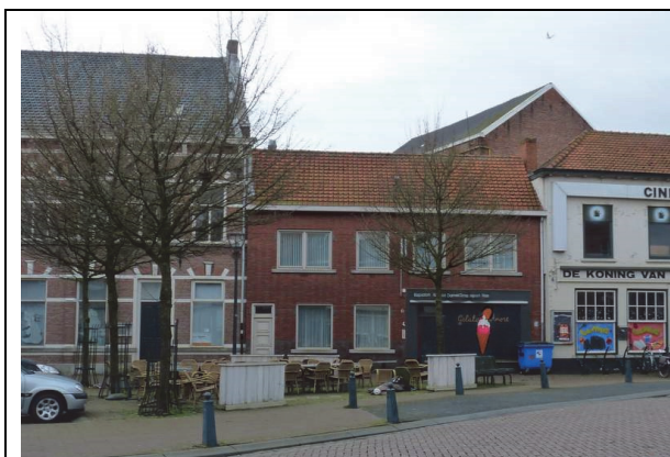
Fig. 3 Overzicht Houtmarkt. Foto genomen richting het zuiden.
