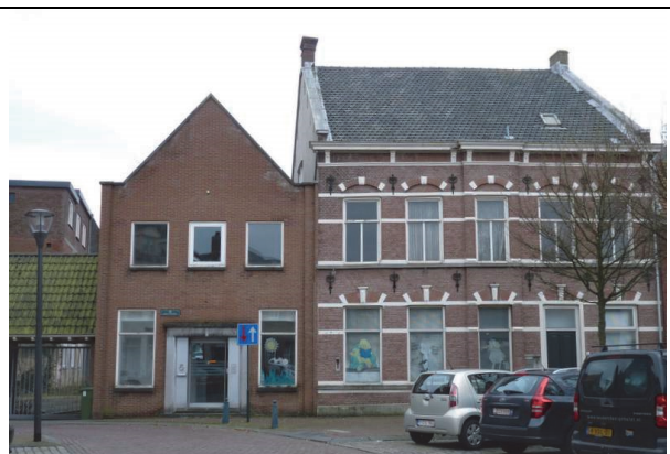
Fig. 8 Overzicht karakteristiek bankgebouw en naastliggend gebouw
