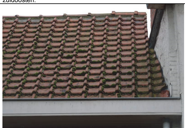
Fig. 6. Openingen aan de rand van het dak, rechts op de foto, geven mogelijkheden voor vleermuizen.
