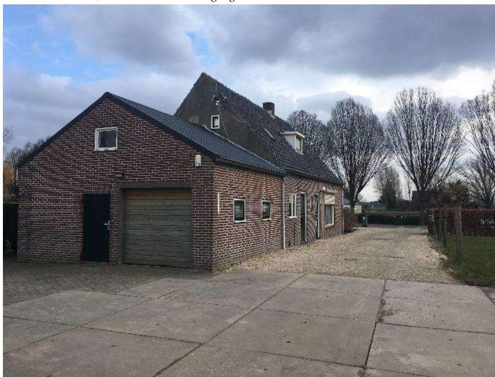
Figuur 2 De woning is opgetrokken uit metselwerk en draagt een pannendak. De jongere aanbouw en losstaande garage hebben een dak van dakpanplaten. Deze zijn mogelijk geschikt voor huismussen en vleermuizen, doordat er openingen aanwezig zijn .
