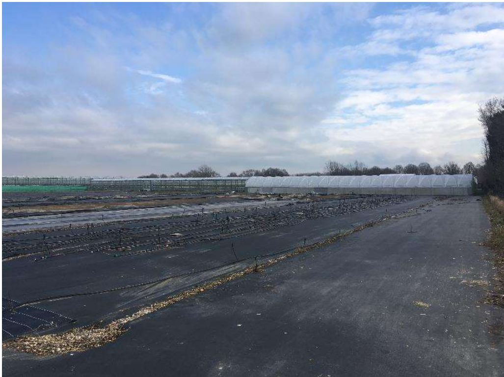
Figuur 4 Het terrein is grotendeels verhard met betonplaten, bebouwd of afgedekt met worteldoek t.b.v. de aardbeienteelt in containers. Op enkele plekken heeft zich kruidachtige vegetatie gevestigd.
