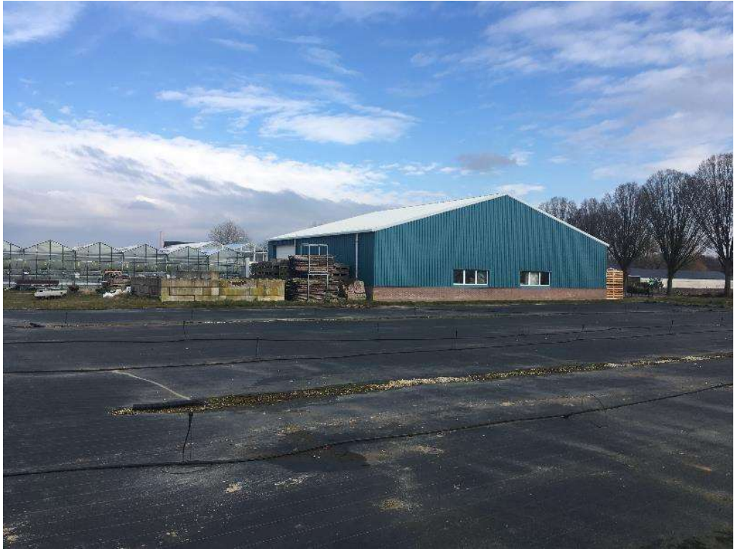
Figuur 5 De schuur is opgetrokken uit metselwerk (tot een hoogte van 1m) en damwandplaten.
