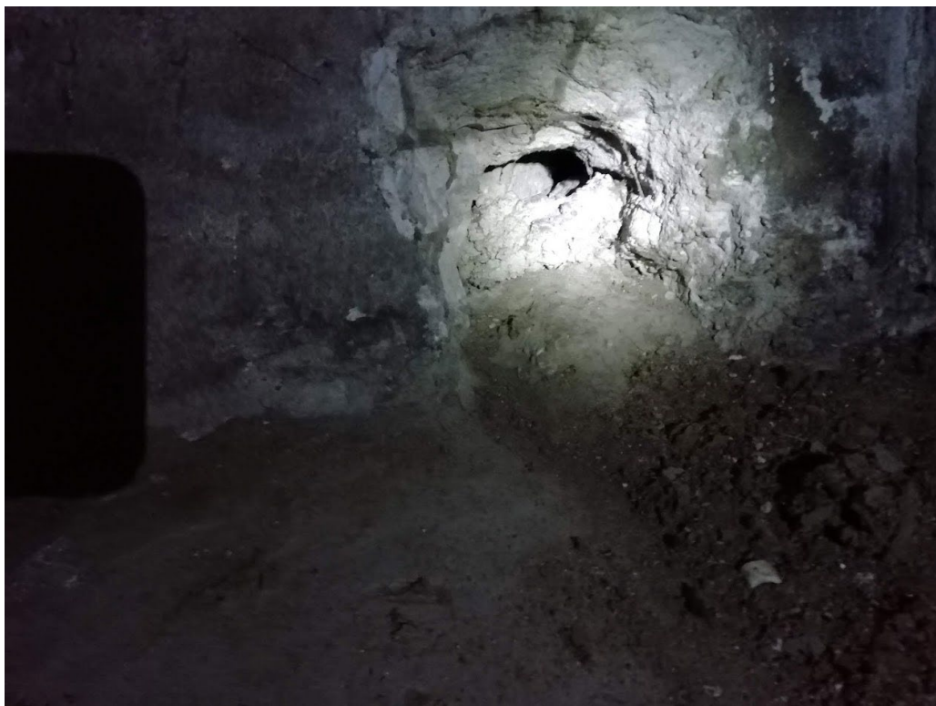
Figuur 3.7: Gaten in binnenmuur met toegang tot spouw.
