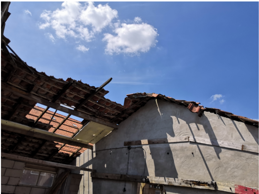
Figuur 3.6: Foto bouwwerk nummer 1 (zie figuur 3.2)
