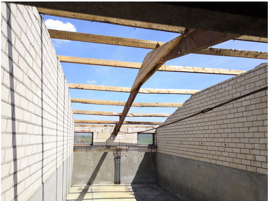
Figuur 3.8: Foto bouwwerk nummer 2 (zie figuur 3.2)
