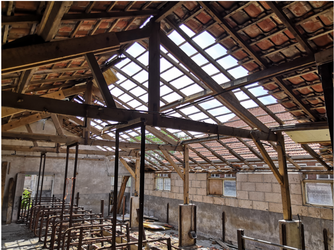
Figuur 3.5: Foto bouwwerk nummer 1 (zie figuur 3.2)
