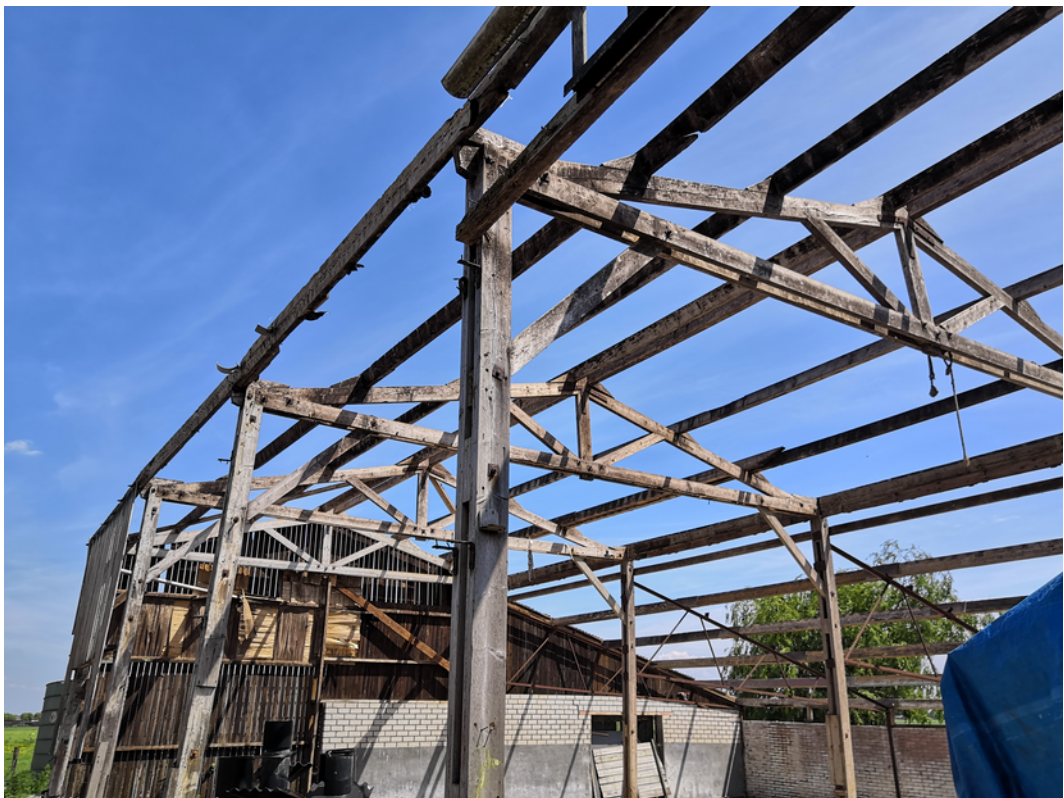
Figuur 3.4: Foto bouwwerk nummer 4 (zie figuur 3.2)
