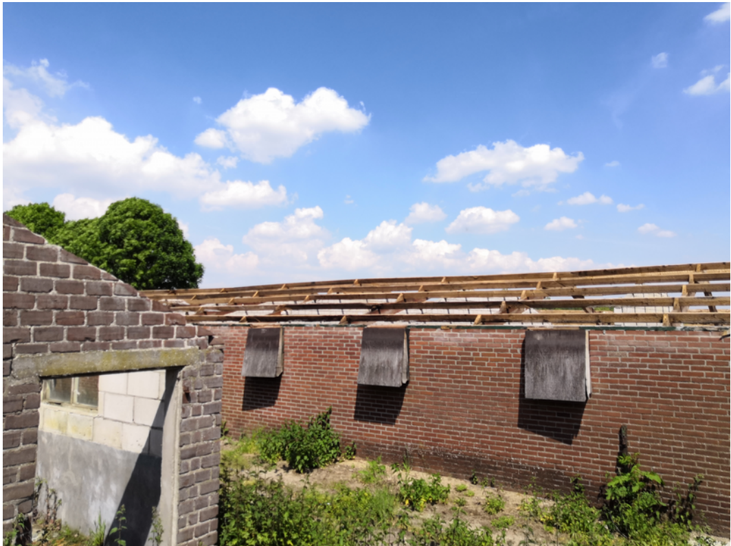
Figuur 3.7: Foto bouwwerk nummer 2 (zie figuur 3.2)
