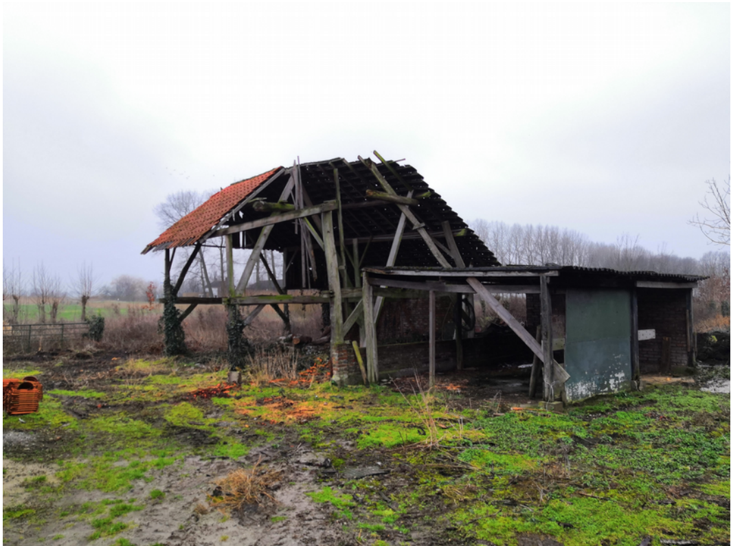
Figuur 3.3: Foto bouwwerk nr. 5 (zie figuur 3.2)
