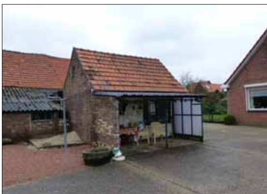
Te slopen bebouwing aan noordzijde
