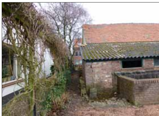
Te slopen bebouwing + buurwoning
