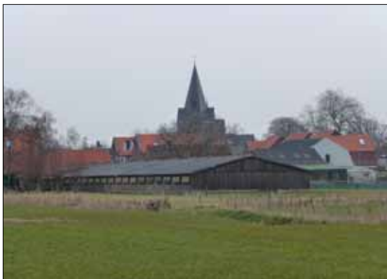
Zicht op te slopen kippenschuren vanaf zuidzijde
