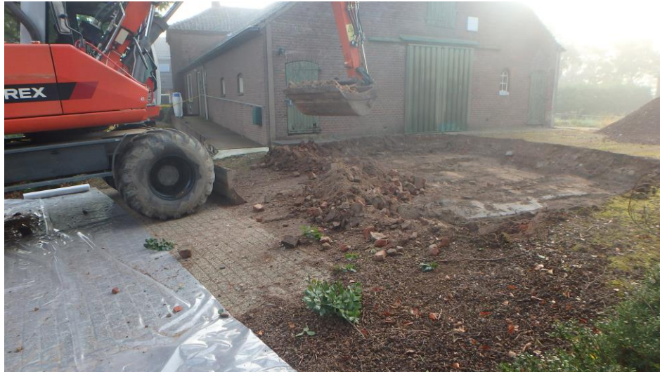
F1 Verwijderen puinverharding
