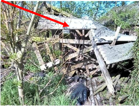
Foto 12 | golfplaten op het dak
