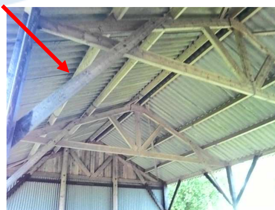
Foto 20 | golfplaten op het dak
