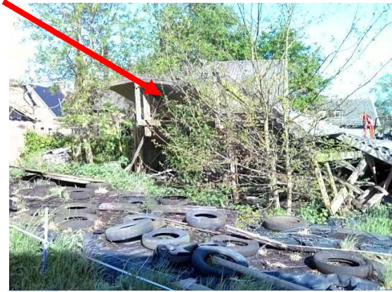
Foto 13 | golfplaten op het dak
