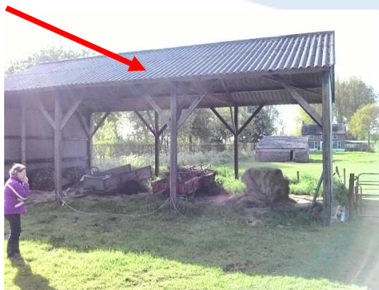
Foto 19 | golfplaten op het dak
