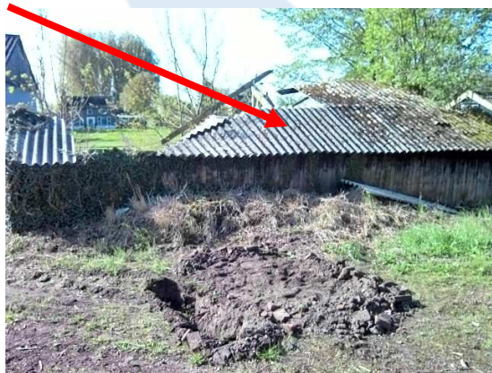
Foto 10 | golfplaten op het dak
