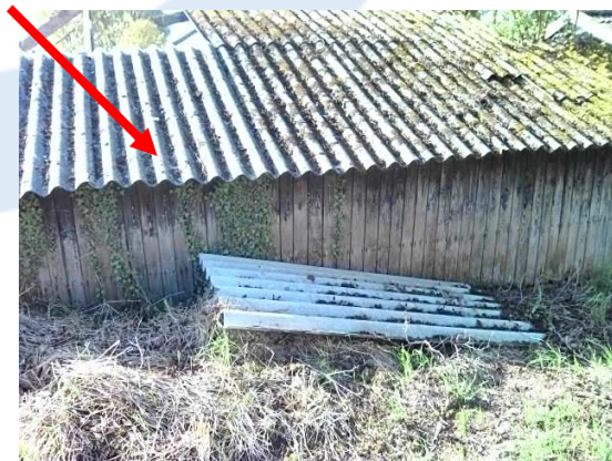
Foto 11 | golfplaten op het dak
