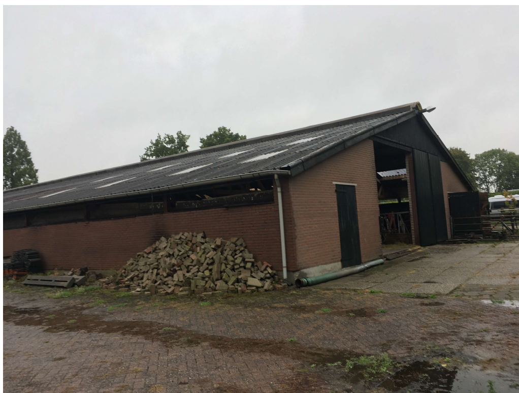
Figuur 4 De veestal is opgetrokken uit gemetselde muren met spouw en draagt een golfplaten dak. Het omliggend terrein is grotendeels verhard.
