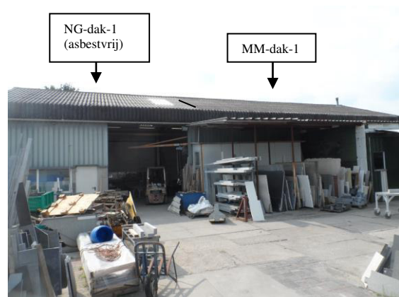
Foto 4: Geïntervieweerde kapconstructie/dakbedekking van de schuur met gedeeltelijk asbesthoudende en gedeeltelijk asbestvrije golfplaat als dakbedekking vanuit oostelijke richting gezien.
