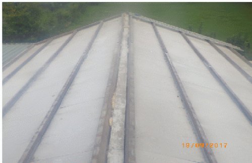
foto 3: Golfplaten en windveren verwijderd
