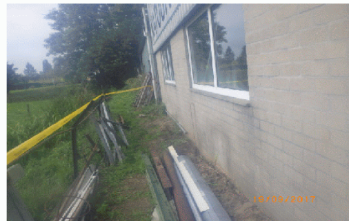
foto 6: Inspectiegebied naast de schuur
