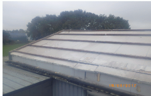
foto 4: Golfplaten en windveren verwijderd
