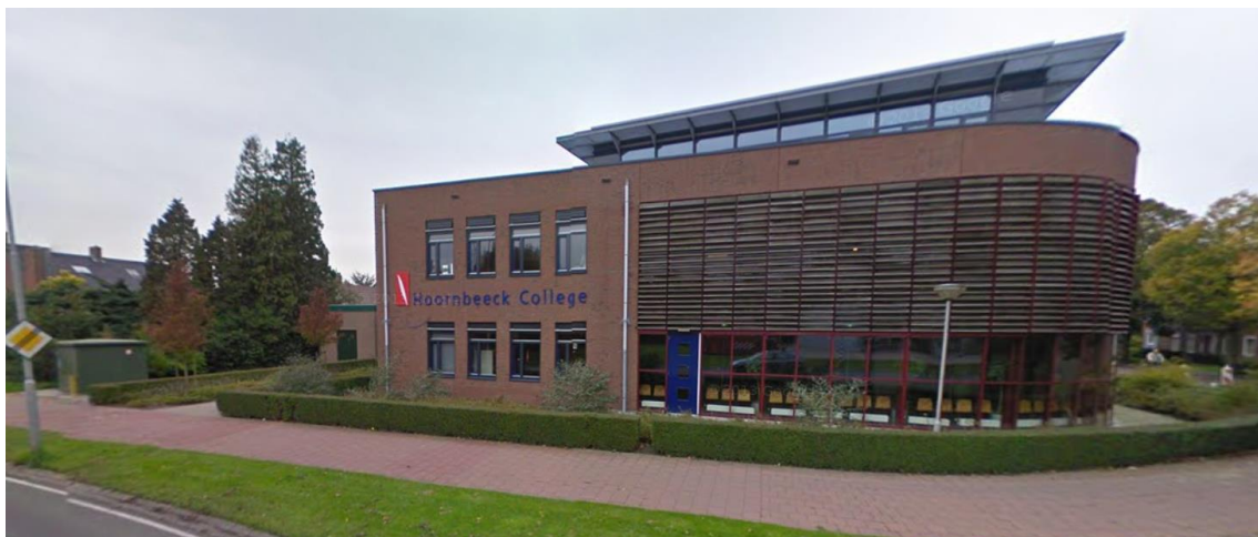
Figuur 2.1 Huidige bebouwing Hoornbeeck College
