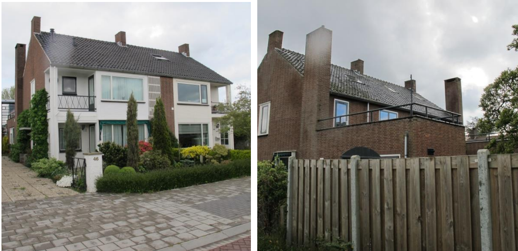
Figuur 3 Voor- en achterkant van de te slopen twee onder-een-kap woningen (dichte muren geen overstekken)
