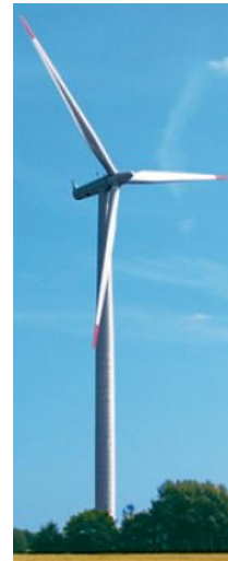
Foto: Siemens SWT-2.3-82
