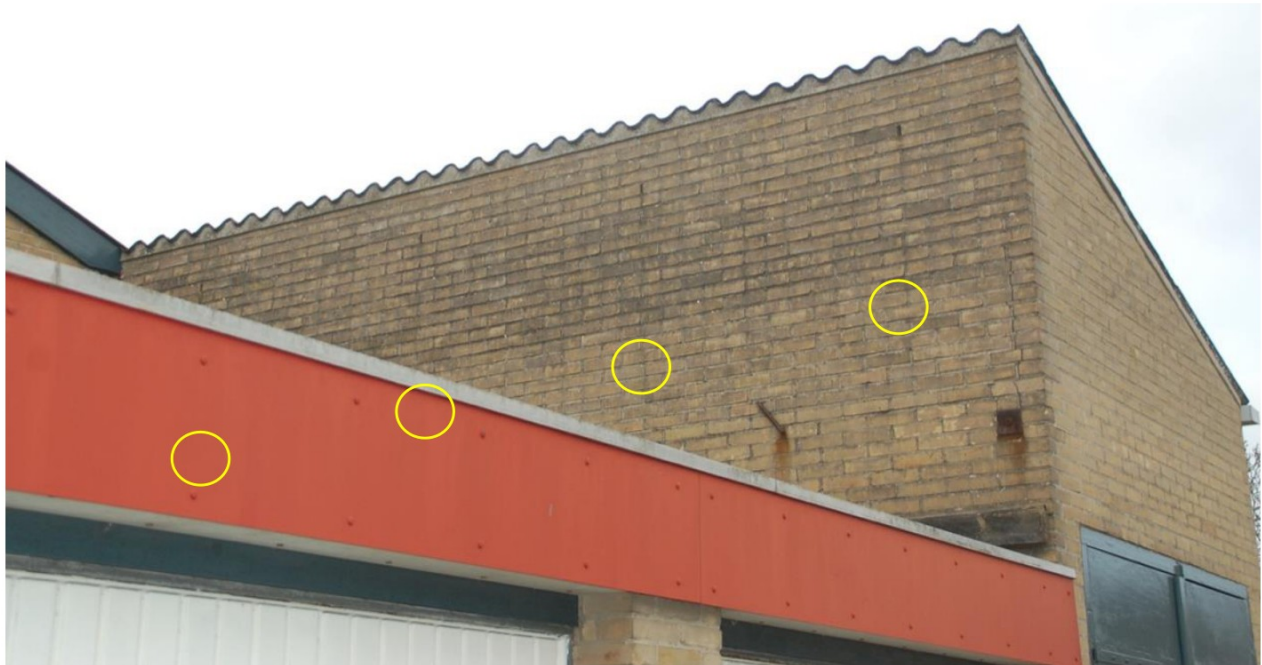
Figuur 6: Achter de open stootvoegen van bovenstaande gevel zijn mogelijkheden voor vleermuizen om te verblijven.
