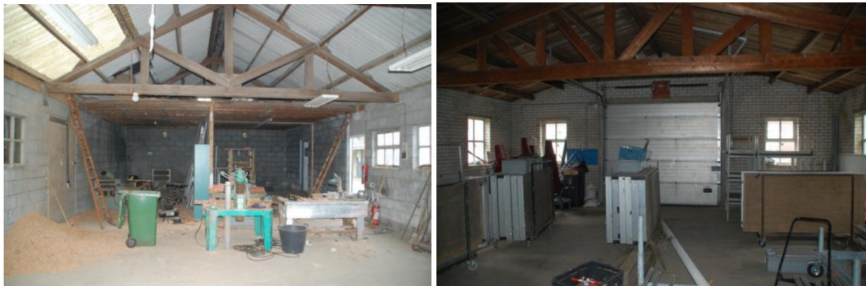
Figuur 9: De verschillende loodsen zijn ongeschikt voor huismus en vleermuizen vanwege het ontbreken van een spouwmuur of enkel asbest dakbedekking. De loodsen zijn ontoegankelijk voor kerkruilen.
