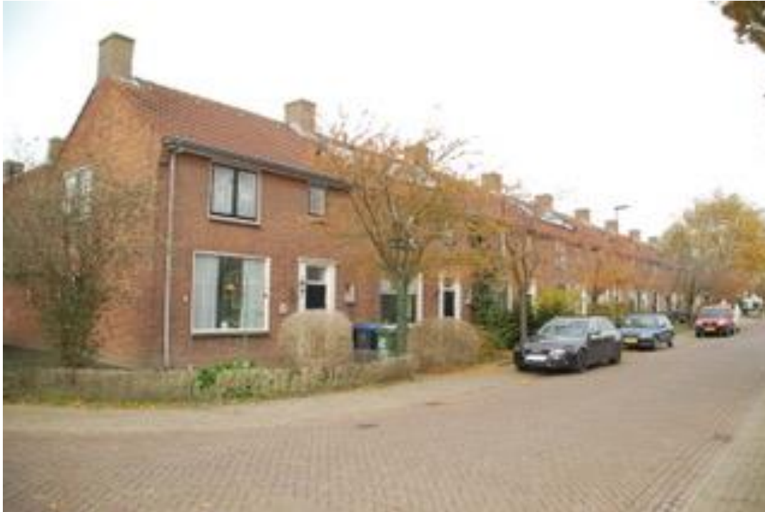
Foto 2. Overzicht te slopen huizen.
