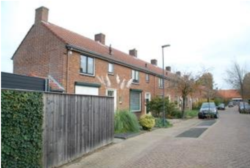
Foto 1. Te slopen woningen.
