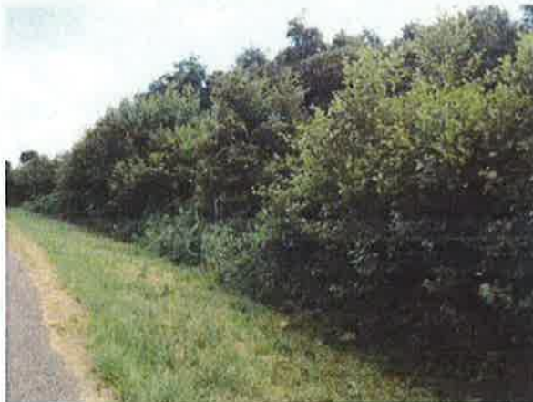
foto 3 middendeel berm en oever
