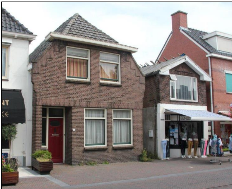
Afbeelding: recent zicht op de projectlocatie aan de Dorpstraat 82-84 te Zoetermeer. Deze panden zijn reeds gesloopt.
