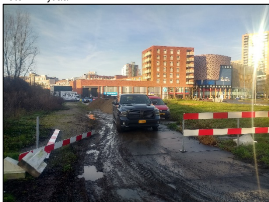
Foto 3: Stelconplaten en halfverharding.
