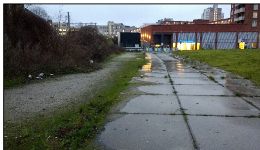
Foto 2: Stelconplaten en halfverharding.
