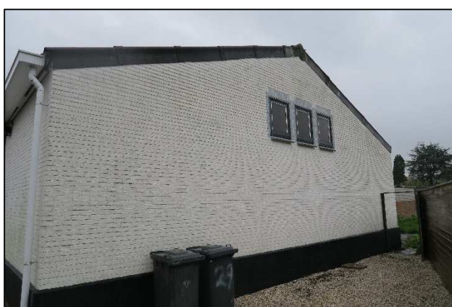
Foto 3. Achterzijde oostelijke opstal met lood flappen
