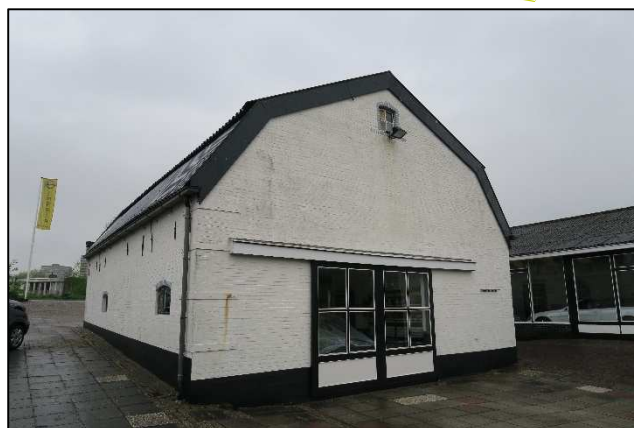
Foto 2. Achterzijde westelijke opstal
