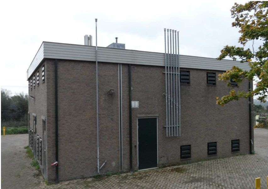
figuur 6 Gasreducerstation met geluidgedempte gevelroosters
