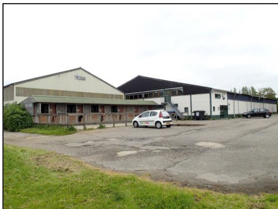
Foto 1: Binnenbakken met bijbehorende opstallen
