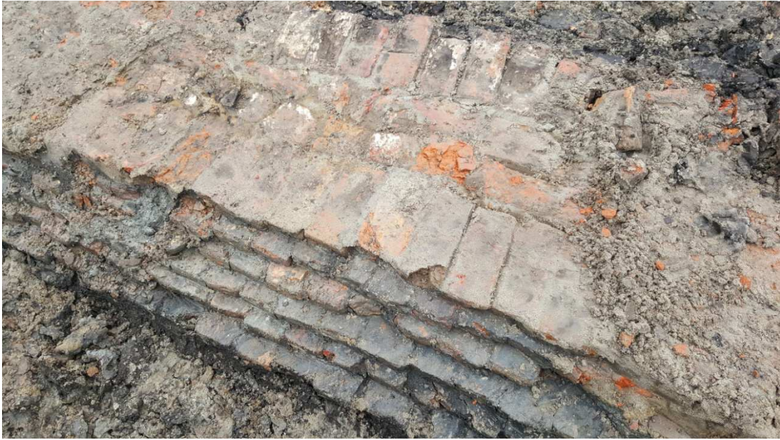
Afbeelding 10 detail fundering buitenmuur S1. Bron: foto Vestigia (04-09-2017).
