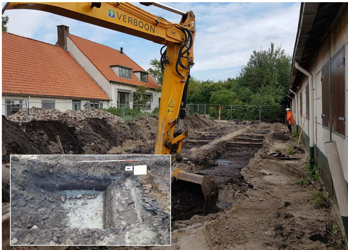
Afbeelding 7 Graven werkput 1, gezien vanuit het zuiden. Inzet: profiel 3 (zie kaart 3 voor locatie) . Bron: foto Vestigia (04-09-2017).
