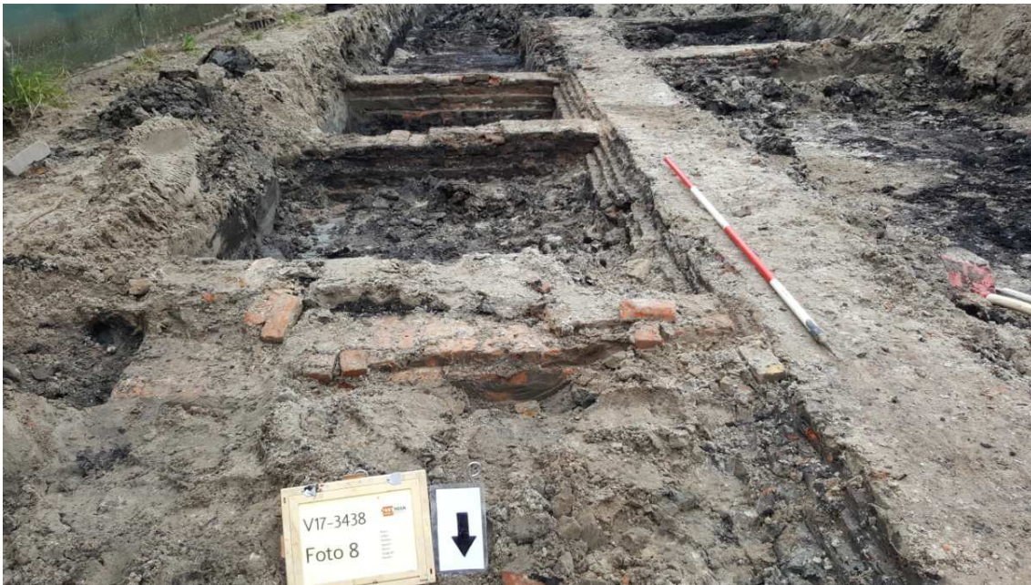
Afbeelding 11 detail zij-muurtjes S5-S6-S7, gezien vanuit het noorden. Bron: foto Vestigia (04-09-2017).
