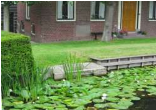
Voorweg 198 Betonnen wassteiger, opgevuld met (grind)tegels
