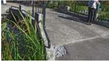
Voorweg bij 182 Gewapend betonnen brug uit 1951
