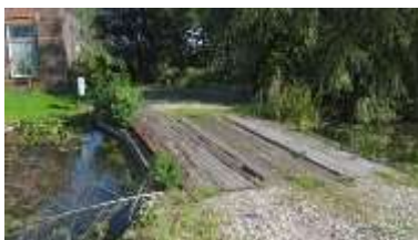
Voorweg bij 232 Gewapend betonnen brug
