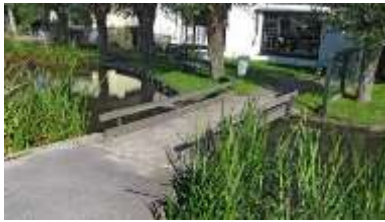
Voorweg bij 214 Gewapend betonnen brug
