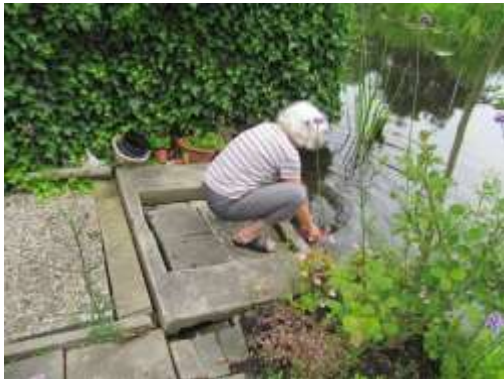
Voorweg 198 Betonnen wassteiger, opgevuld met (grind)tegels
