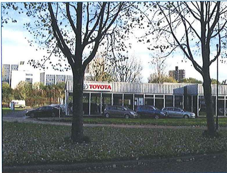
Figuur 10 zicht op de binnen het deelgebied aanwezige garage
